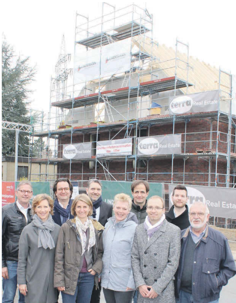
Beim Richtfest: Andreas Tietz (hi., 2. v. li.), Geschäftsführer von terra Real Estate, und sein Team Foto: ce
