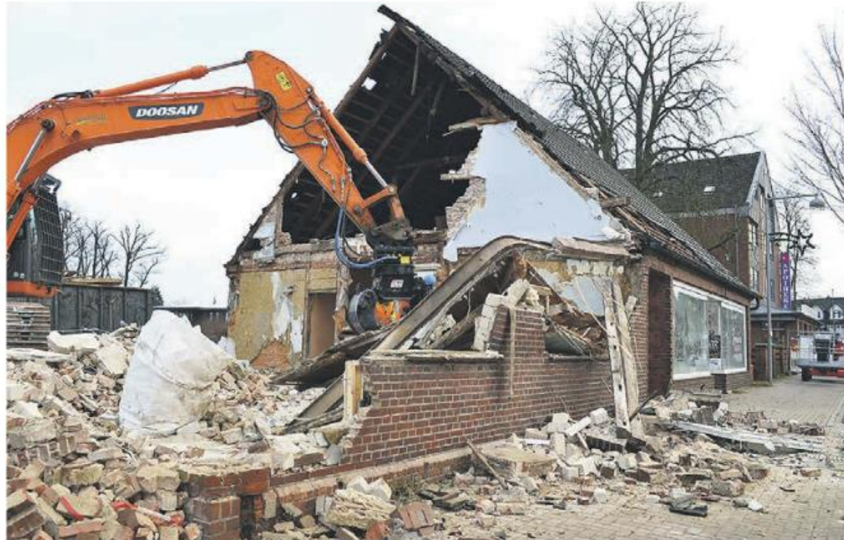
Das Gebäude Bahnhofstraße 25 in Tostedt wurde jetzt abgerissen Foto: bim
