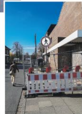
Der Fußweg vor den Abrisshäusern ist derzeit gesperrt
