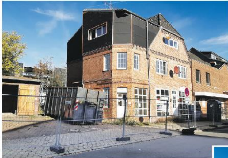
Erst wurde innen vorbereitet, in Kürze wird dieses Haus an der Bahnhofstraße abgerissen Fotos: os
